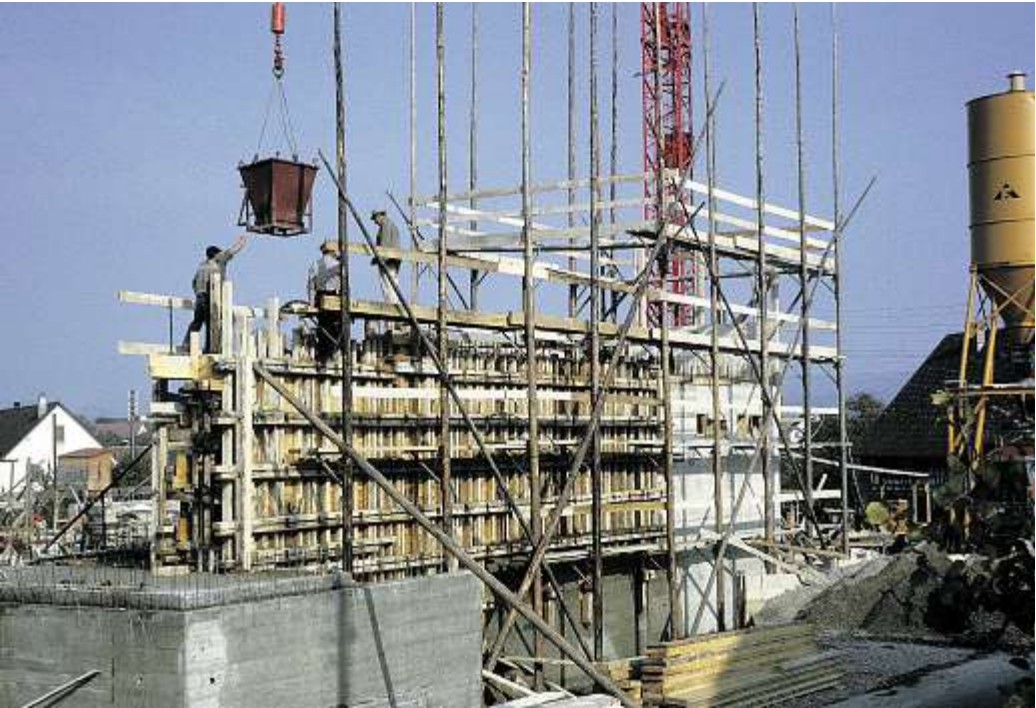
Für die Wände aus Sichtbeton wurde eigens Kies aus dem Zürcher Oberland herbeigeschafft. Der Weiacher Kies war für den Architekten Ernst Gisel zu gelblich.
