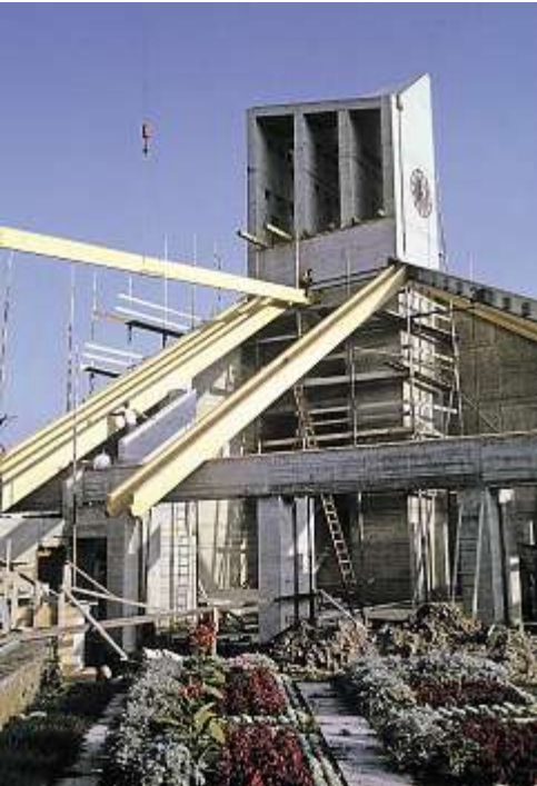
Noch fehlt das Dach...
