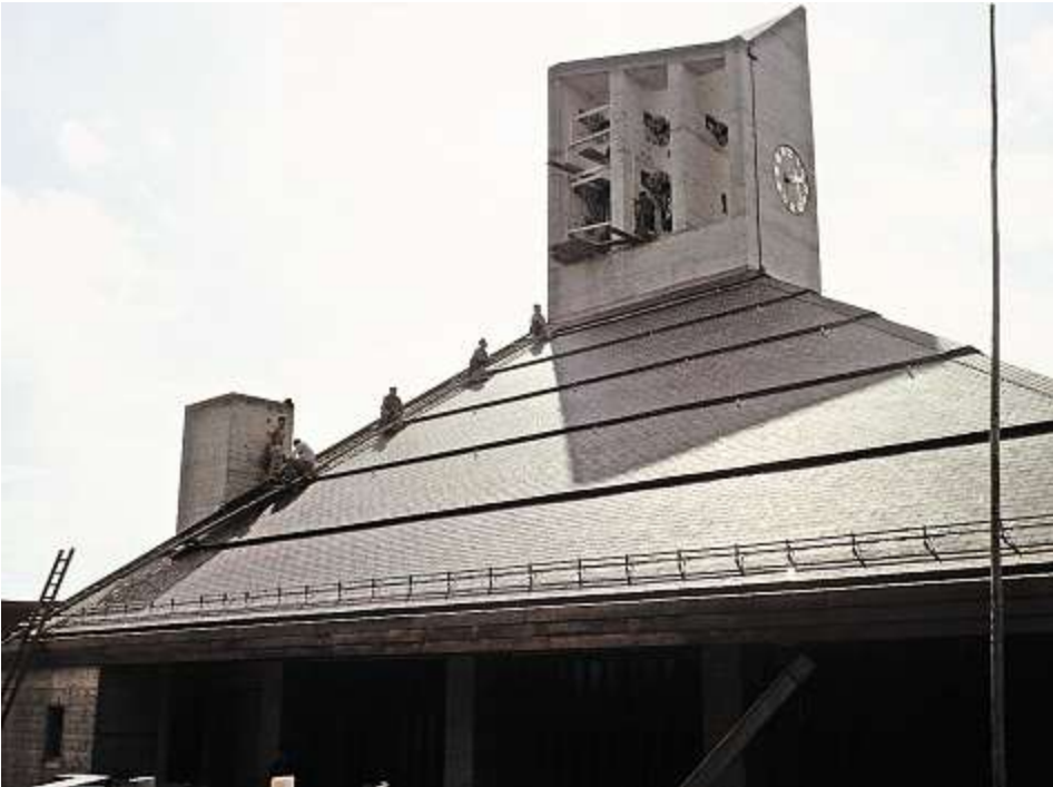
... aber nicht mehr lange: Die Dachdecker in den letzten Zügen.
